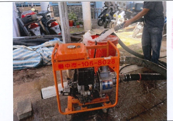
105-S029-08-抽水機運轉中
