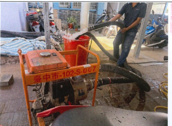
102-S007-08-抽水機運轉中
