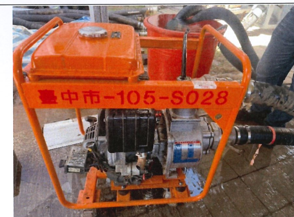
105-S029-07-抽水機試車前
