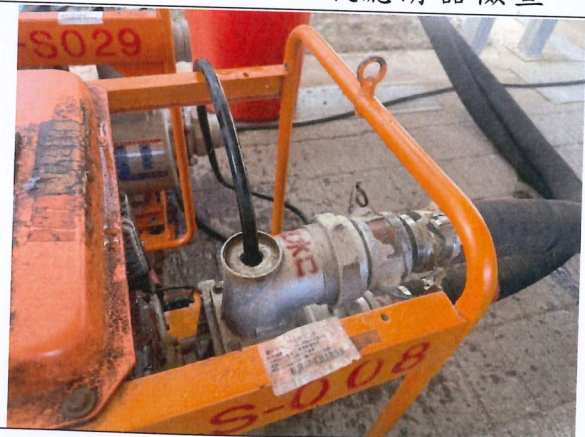
102-S008-07-抽水機試車前
