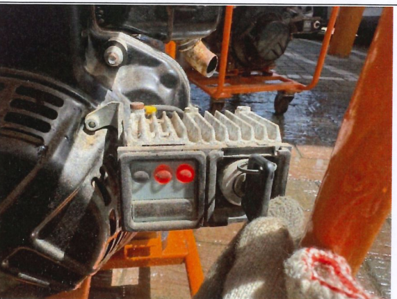
105-S028-07-抽水機試車前
