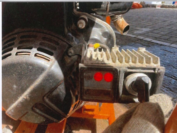
105-S029-07-抽水機試車前
