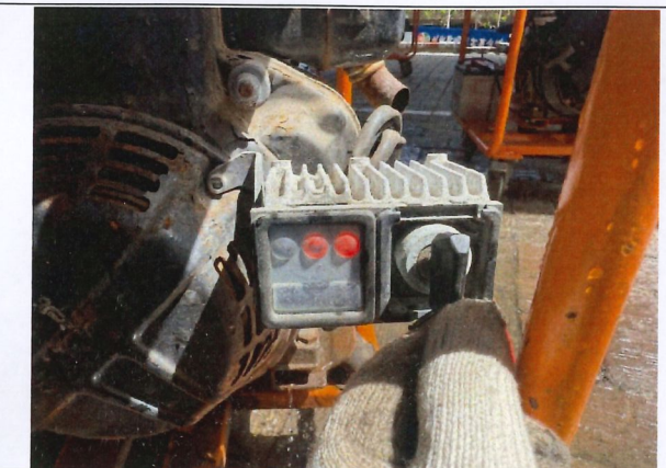
102-S008-07-抽水機試車前
